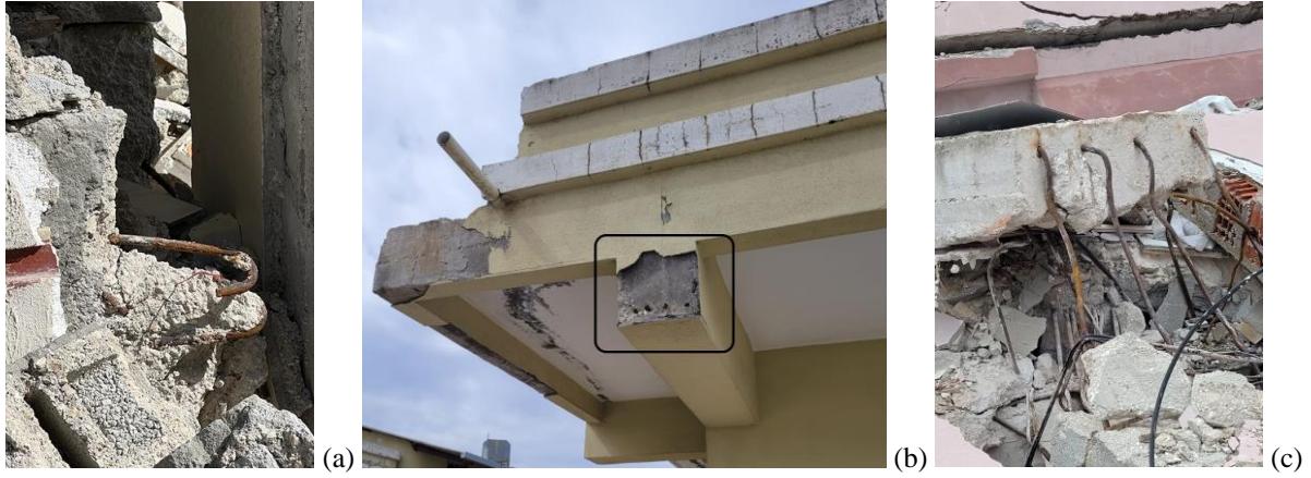
Şekil 7: Hatalı donatı uygulamaları.
