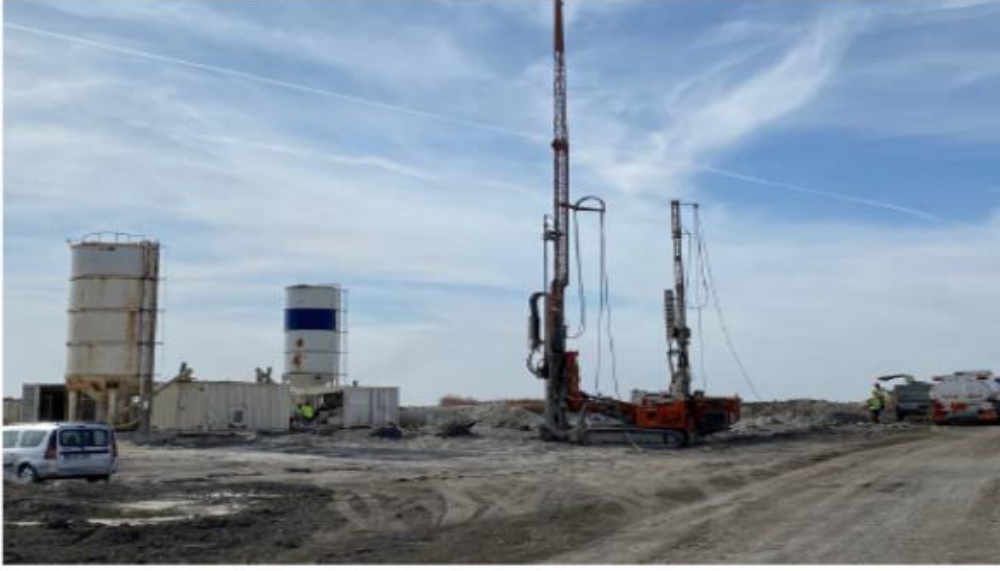
Şekil 2: Jetgrout saha çalışması.
