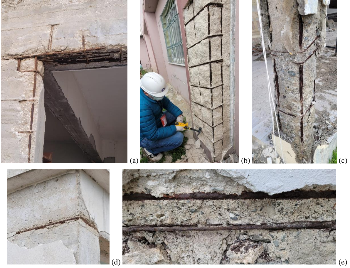
Şekil 6: Korozyon hasarları.
