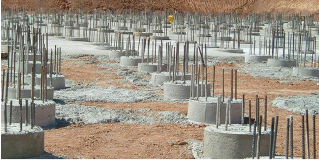
Şekil 5: Fore kazık yapım işleminin zemin içerisindeki yapım işleminin tamamlanmış hali.
