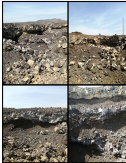
Şekil 3. İnceleme alanı arazi görünümü
