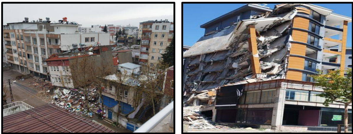
Şekil 4. Farklı hasar durumlarına sahip betonarme yapılar
