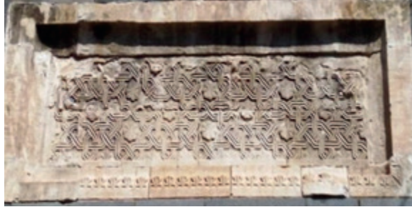
Foto 12: Behram Paşa Camii MinareKaidesi, Batı Pano (Zorlu, 2018)
