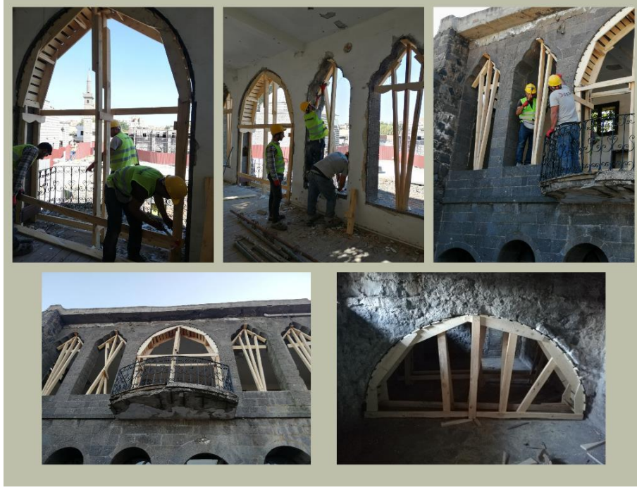
Şekil 22. Askılama İşlemi Hazırlık ve Uygulama Aşamaları.
