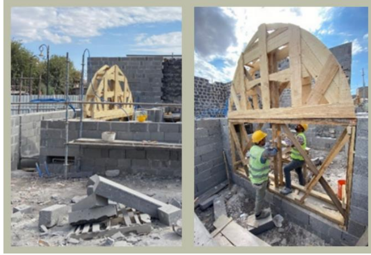
Şekil 36. Kemerlerin Oluşturulması İçin Kalıp İskelesi Kurulumu.
