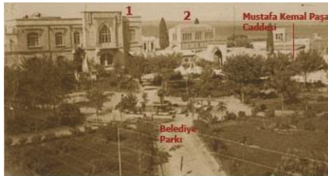
Şekil 21. Urfa Belediye Parkı. Eski Belediye Binası (Uray Oteli) (1) ve Park Oteli (2) (Kürkçüoğlu, 2011)
