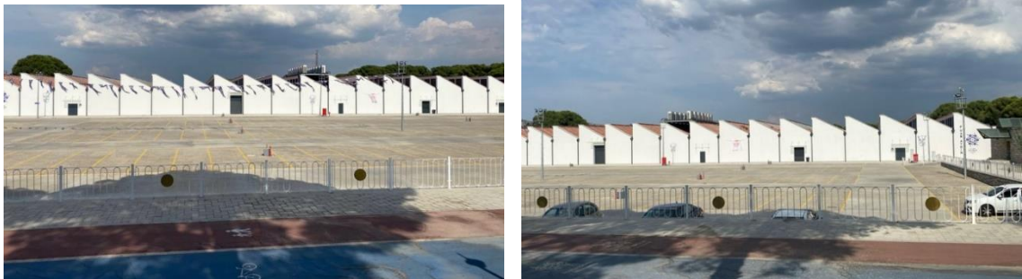
Şekil 37: Restorasyon Çalışmaları Yapılmış Olan Üretim Yapılarının Görünüşleri, Kişisel Arşiv, 2024
