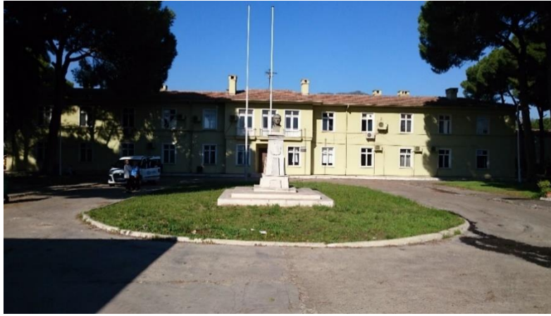
Şekil 10: Restorasyon öncesi Aydın Tekstil Fabrikası Yerleşkesi İdari Binası, Aydın Büyükşehir Belediyesi, Kent Tarihi ve Tanıtımı Daire Başkanlığı
