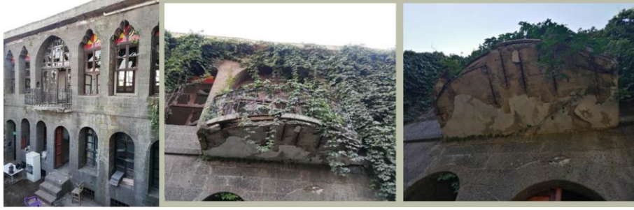
Şekil 16. Yapıya Avluya Bakan Güney Kanadı Cephesi ve Sonradan Eklenen Metal Donatılı Betonarme Balkon.
