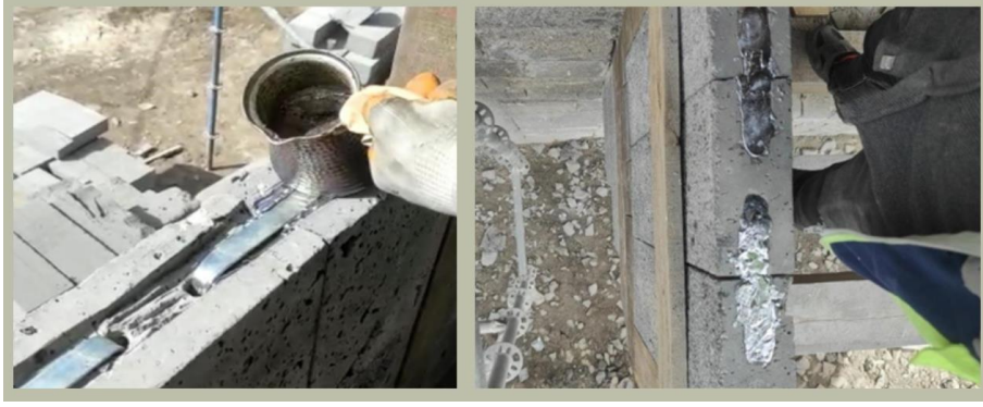
Şekil 28. Kurşun ile Taşların Kenetleme İşlemi.
