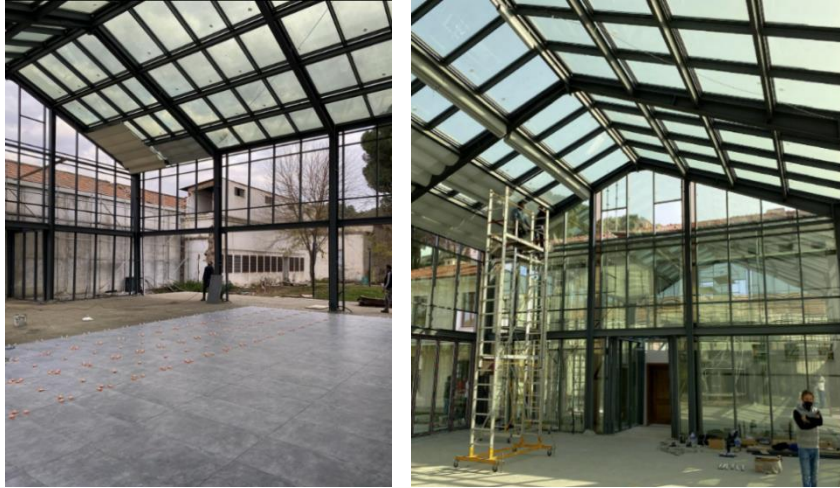
Şekil 13: İdari Yapı ile Üretim Yapısı Arasında İnşa Edilen Yapı, Etm Mimarlık, 2022
