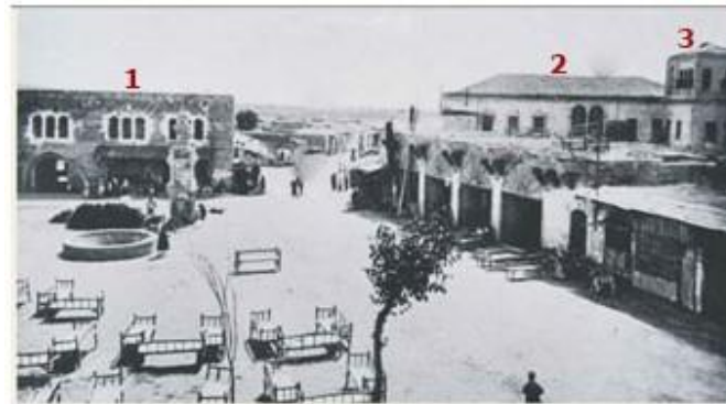
Şekil 19. Köprübaşı Hanı (1), Hacı Kâmil Konağı (2) ve Hacı Kâmil Köşkü (3) (Kürkçüoğlu, 2011)
