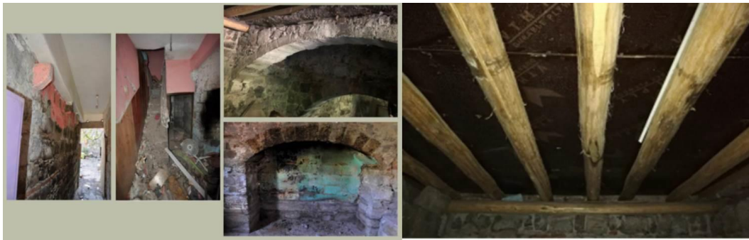
Şekil 17. Özgün Taş Üzerine Yağlı Boya ile Yapılan Müdahaleler ve Bodrum Kirişlerinin Üstüne Yerleştirilen Yeni Plywood Panel.
