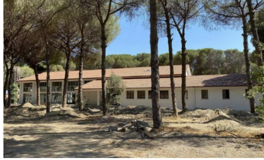
Şekil 25: Yemekhanenin Restorasyonu Yapılırken Görünüşü, Etm Mimarlık, 2022
