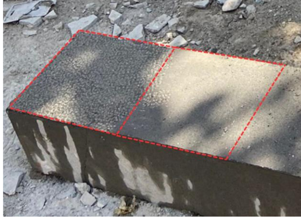
Şekil 20. Mucarta İşlemi Yapıldıktan Sonra ve Önce Taş Yüzeyinin Görüntüsü.
