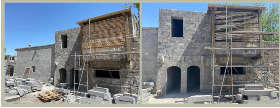
Şekil 29. Bağdadi Çıtaların Yerleştirilmesi.
