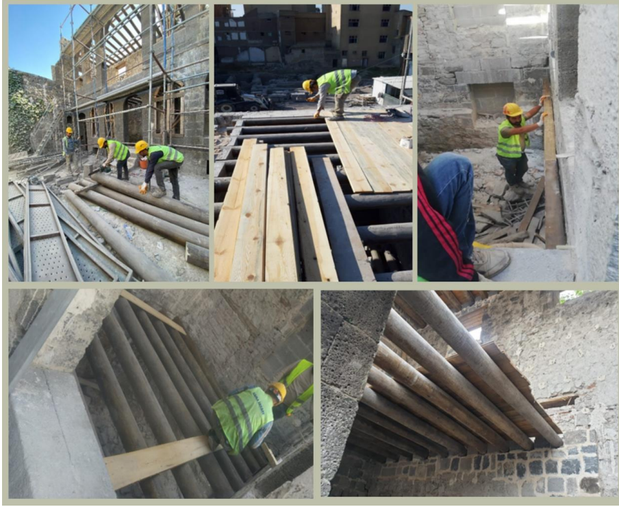
Şekil 33. Konuttaki Ahşap Malzemelerin Yenilenmesi.
