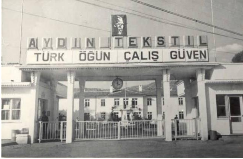
Şekil 33: Aydın Tekstil Fabrikası Ana Girişi, Aydın Tekstil Fabrikası, 2010
