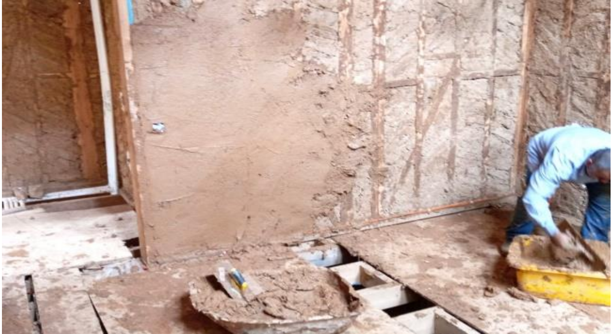
Şekil 12. Ahşap duvar üzeri kerpiç sıvanın kaba aşaması
