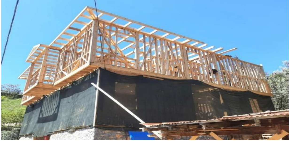
Şekil 7. Taş duvar, ahşap karkas
