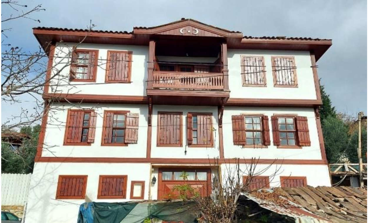
Şekil 18. Akın Evi'nin bitmiş hali ön cepheden görünüşü
