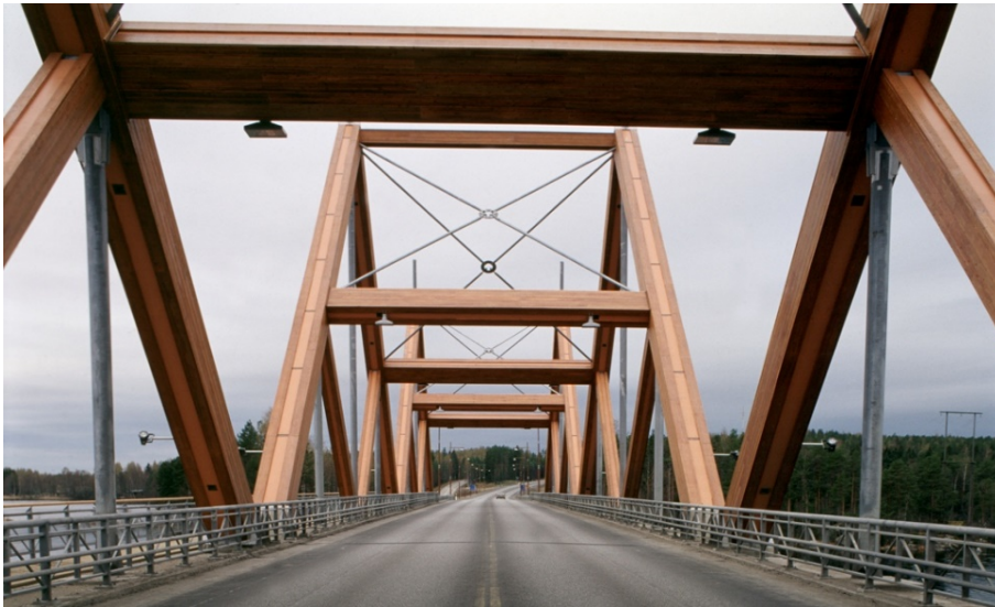
Şekil 1. Mikko Junninen, Vihantasalmi köprüsü.
