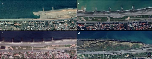
Şekil 2. Çalışma alanının yıllar içindeki değişimi (Google Earth, a:2002-b:2010-c:2019-d:2024)
