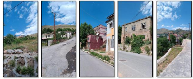
Şekil 3. Bitlis ili Gazibey mahallesi kuzey kesimi çığ tehlikesi altındaki konutlar
