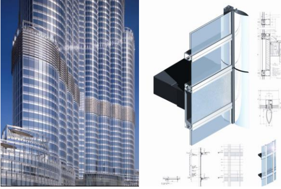
Şekil 7. Dış yüzeydeki yansıtıcı camlar [27].
