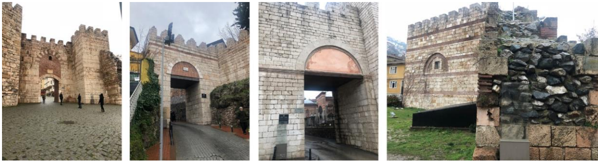
Şekil 6. Hisar Bölgesi'nin girişleri: Saltanat Kapısı, Tahtakale Kapı, Yer Kapı, Fetih Kapısı (Yazar Fotoğraf Arşivi)
