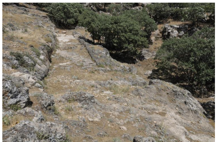
Fig. 2: Rock-Cut Road near the Begani Reliefs. Begani Kabartmaları Yakınında Anakayaya Yontulmuş Yol (R. Bozkurttan).
