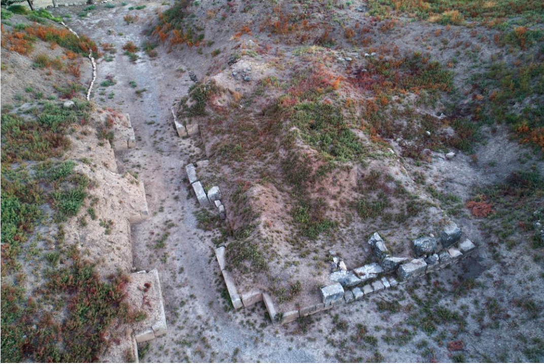
Fig. 10: Orta Tunç Çağı şehir kapısının koruma çalışmaları öncesi genel durumu (Fotoğraf M. Akar).
