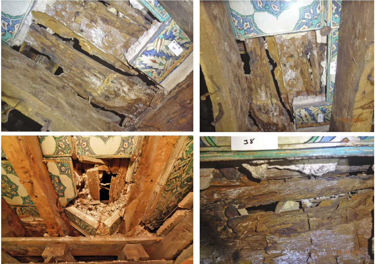
11 Kanvas söküldükten sonra Hünkâr Sofası yönündeki çinili tavanda görülen bozulmalar (Güryapı Arşivi)
