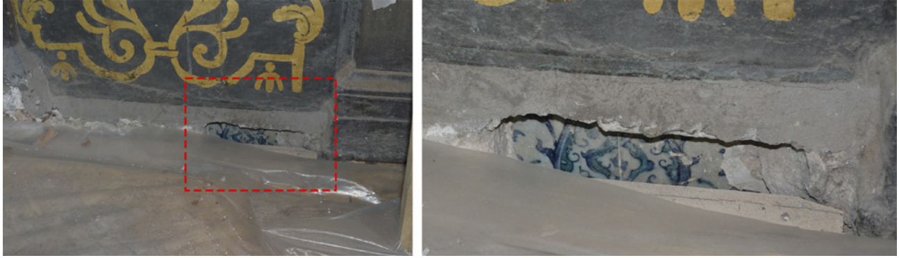
14 Sultan I. Abdülhamid Odası’nda süpürgelik seviyesinde yapılan sıva onarımları sırasında bulunan 17. yüzyıl çinileri (Furkan Al)
