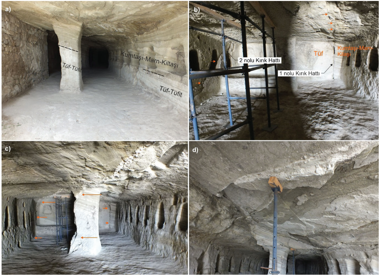
Şekil 12. At Ahırı olarak adlandırılan kaya oyma yapının jeolojik yapısı, (a) litolojik değişimlerin görünümü, (b ve c) kırık hatlarının yönelimi, (d) tavan bölümünde bozunma ve duraysızlıklar.
