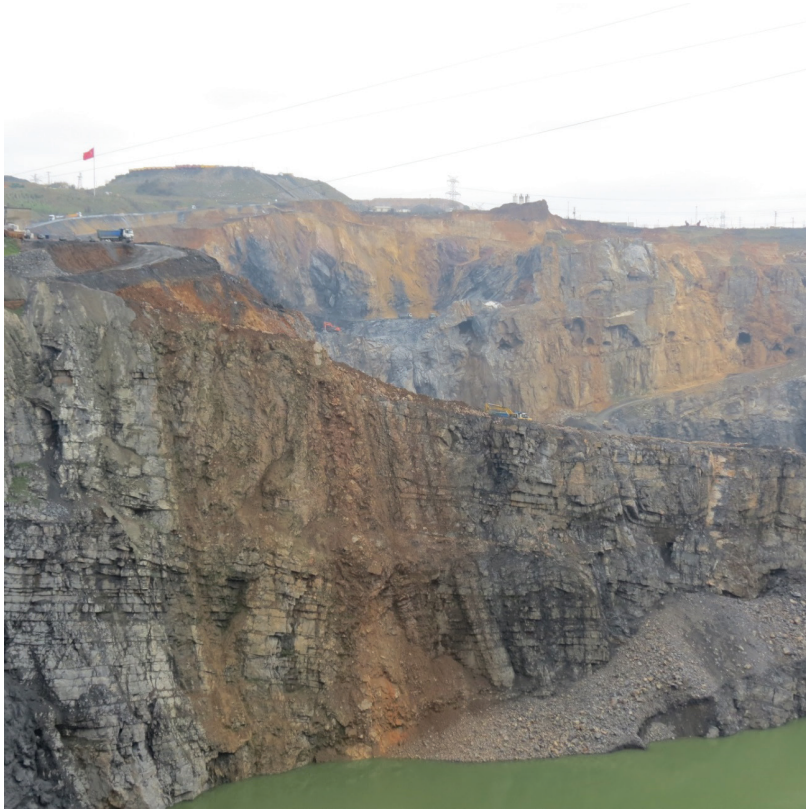
Şekil 4. Agregada üretimi yapılan ve Trakya formasyonu içerisinde bulunan kireçtaşlarının genel görünümü.
