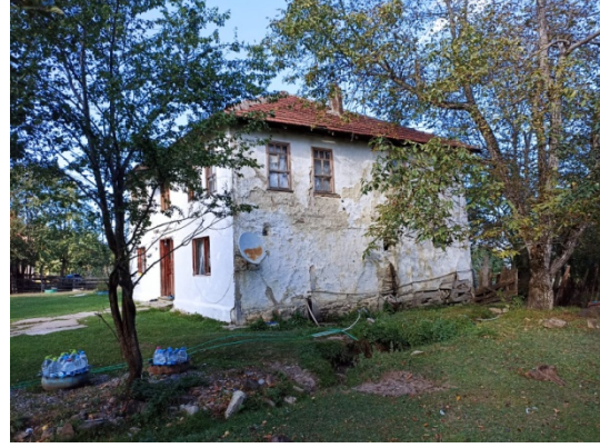
Görsel 25. Yapı cephesinde gerekli bakımları yapılmaması sonucu su ve nem kaynaklı boyada kabarma, dökülmeler ve toprak malzemede çatlakların oluşması
