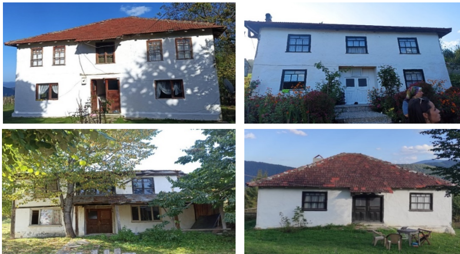
Görsel 13. Derdin köyü giriş cephe düzeni
