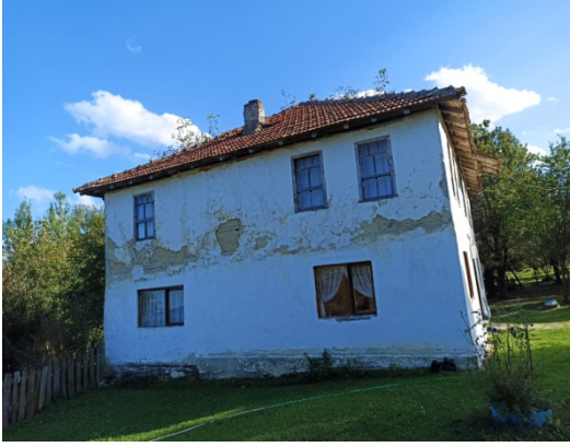
Görsel 25. Yapı cephesinde gerekli bakımları yapılmaması sonucu su ve nem kaynaklı boyada kabarma, dökülmeler ve toprak malzemede çatlakların oluşması
