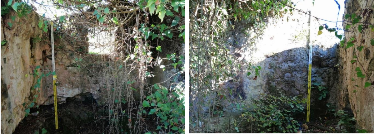
Fotoğraf 28-29. Mekânın İç Tarafından Batı ve Doğu Duvarı
