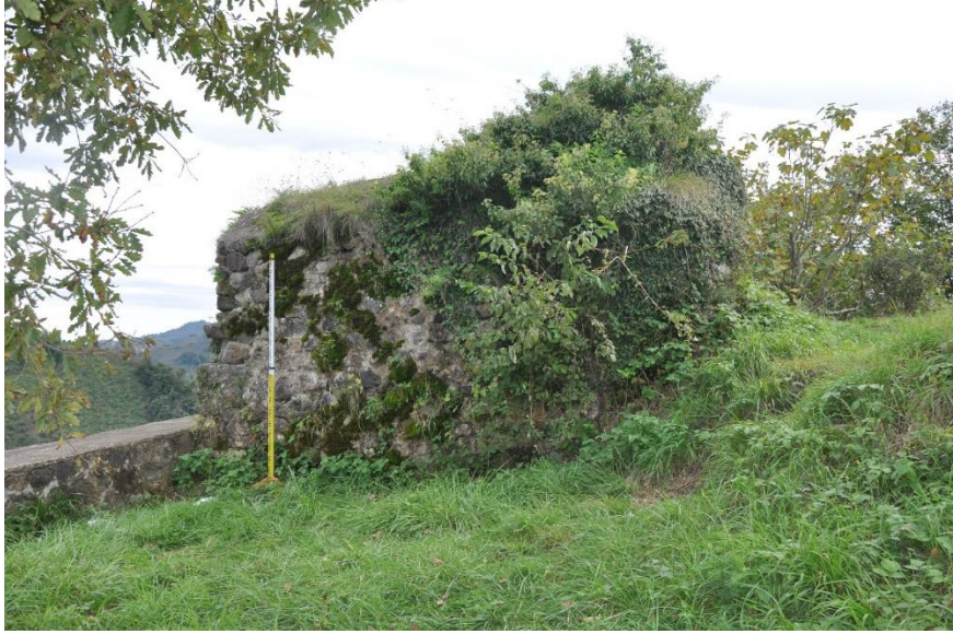
Fotoğraf 27. Mekânın Kuzey Cephesi Görünümü
