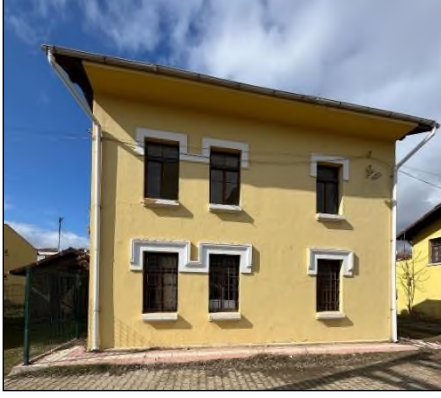
Şekil 16. Lojman I Doğu Cephe.
