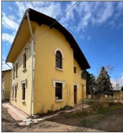
Şekil 18. Lojman I Kuzey Cephe.
