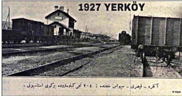
Şekil 10. Ankara-Kayseri-Sivas hattında: 204. kilometrede Yerköy istasyonu. (H. Uyar arşivi)
