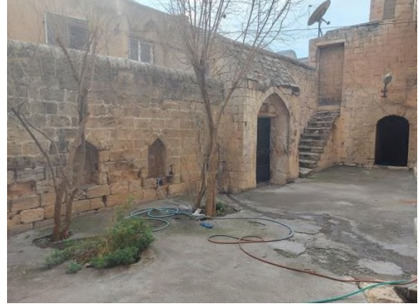
b- Avluya girişi sağlayan kapı
