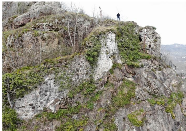
Res. 10: Güney Cephe Sur Duvarları
