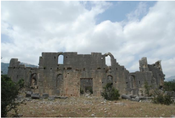
Res. 1: Akören Güney Kilise Güney Cepheden Genel Görünüm
