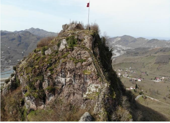
Res. 13: Giriş Kapısı Önündeki Basamaklar
