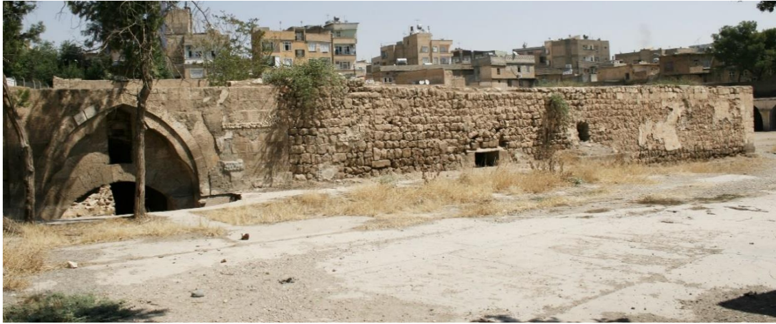
Res. 2: Kuzey avlunun güney duvarı ve Aslanlı Kapı'nın görünümü
