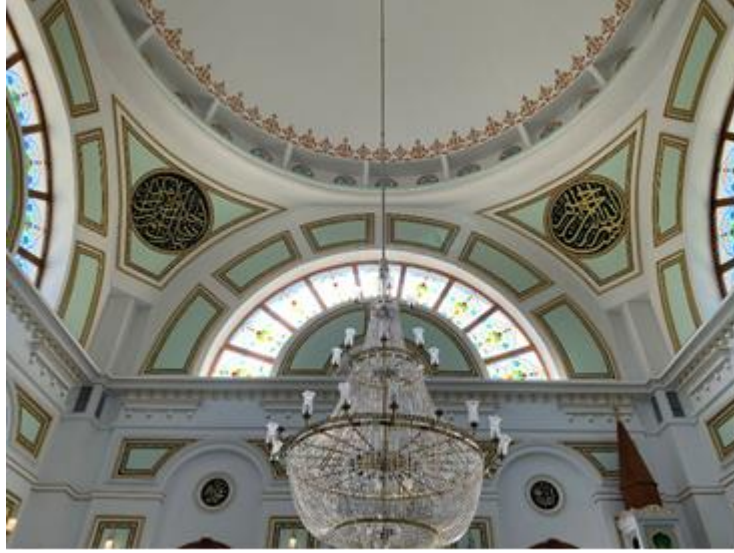
Res. 17: Boşaltma Kemerü Üzerindeki Pencere Düzeni
