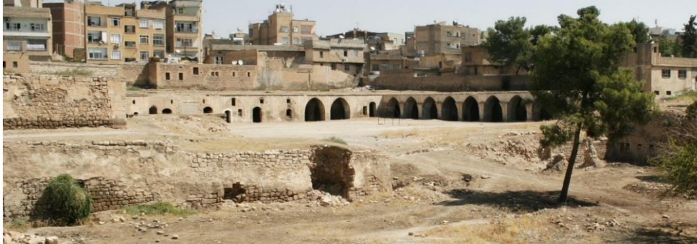
Res. 13: Güney avlu, kuzey kanat
