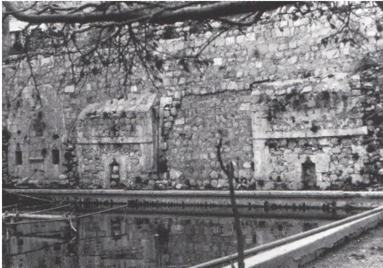
Şekil 10.Hamza-i Sağır Zaviyesi Batı Duvarı Yapı İzleri
