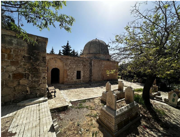
Şekil 28.Hamidiler Türbesinin cepheden görünümü
