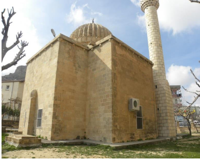
Şekil 8.Hamza-i Kebir Türbe Güneydoğu köşeden görünüşü
