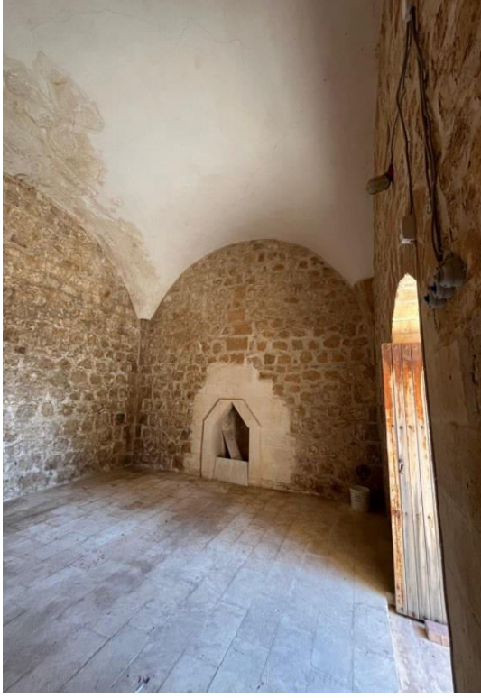
Şekil 17.Cihangir Zaviyesi Giriş açıklığı sonrası girilen mekân
