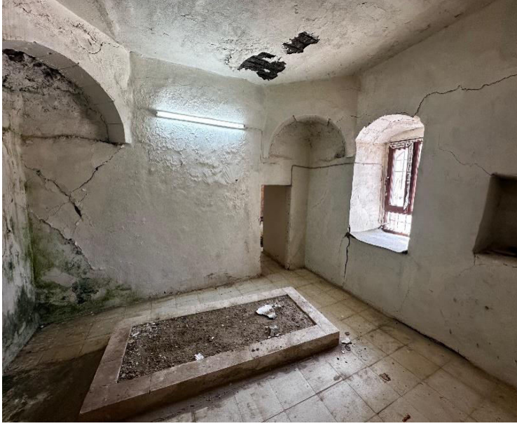
Şekil 31.Hamidiler Zaviyesinin kuzeyindeki mezar yapısı
