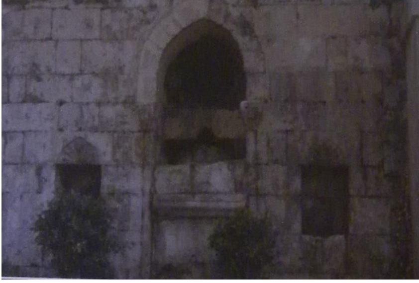
Şekil 11.Batı Duvardaki Çeşme Ayrıntıları
