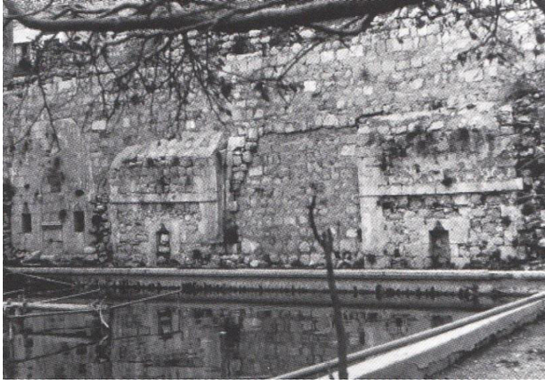
Şekil 10.Hamza-i Sağır Zaviyesi Batı Duvarı Yapı İzleri
