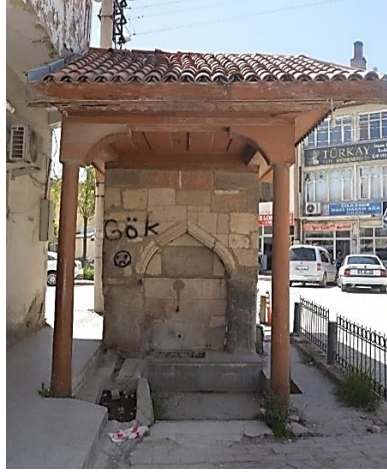
Fotoğraf 10. Cilkoğlu Çeşmesi Kuzey Cepheden Görünüm
