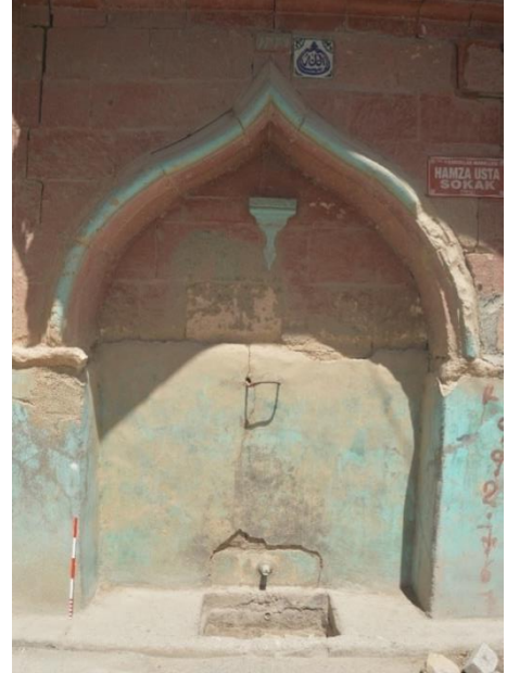
Fotoğraf 22. Palta Çeşmesi Batı Cepheden Görünüm
