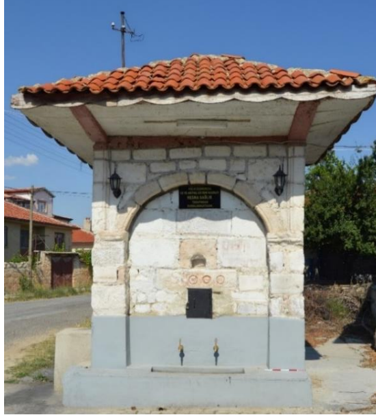
Fotoğraf 19. Kışla Çeşmesi Batı Cepheden Genel Görünüm
