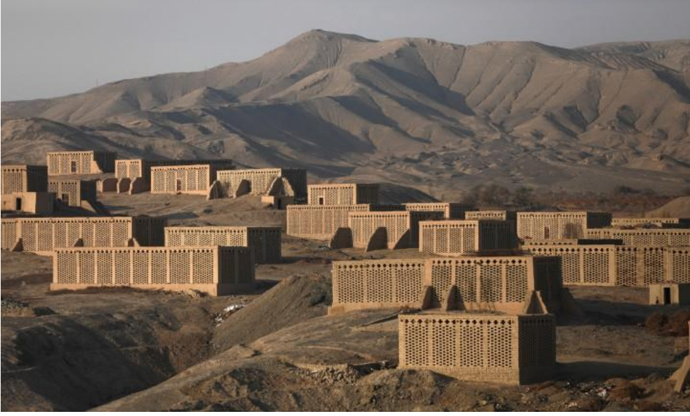
Şekil 3. Turfan Bölgesinde Üzümleri Kurutmak İçin Geliştirilmiş Binlerce Yıllık Geleneğe Sahip Çünçe Evleri
