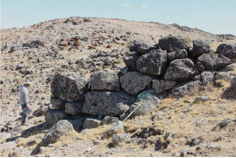
Figür 12. Havuz-Aslantaş; Aşağı Kale'den Batı'ya doğru bakıldığında görülen Zwinger platformunun destek duvarı (Fotoğraf: F. Ayvazoğlu, Havuz-Aslantaş / Karaseki Projesi, 2022).
