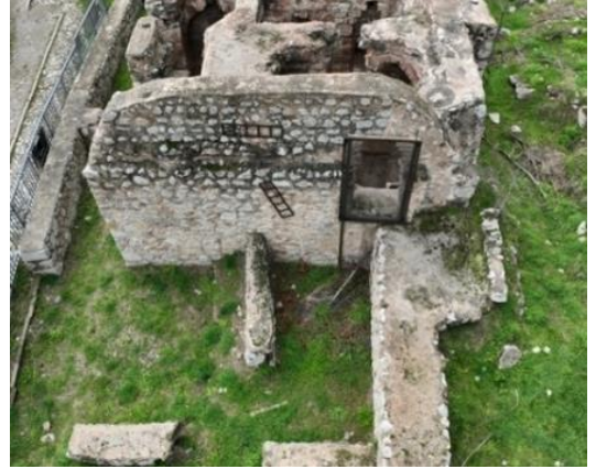
Resim 3. Doğu cephesi görüntüsü
