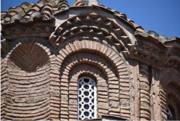
Görsel 9: Azize Ekaterini Kilisesi, kademeli/içe çekik kemer ve konşe detayı Kaynak: yazara aittir-Ağustos 2022
