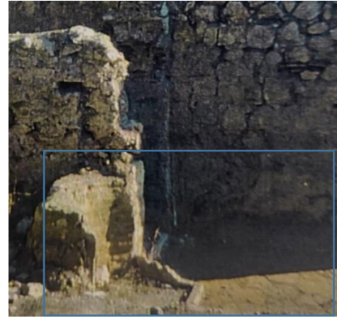
Resim 25. Küçük Hamam soyunmalık ocak nişi ve zemin
