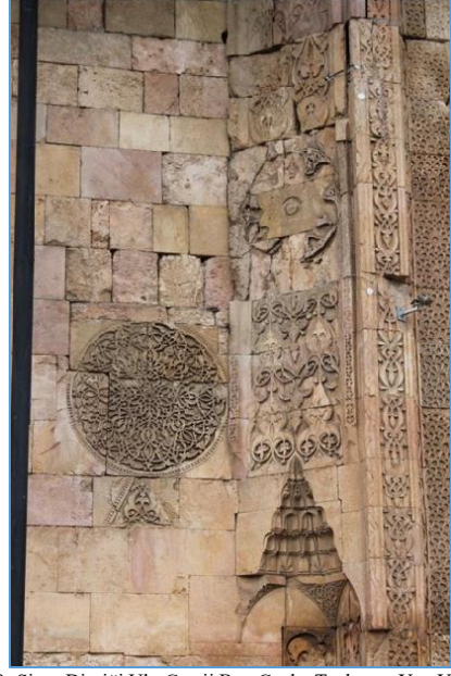
Resim 40: Sivas Divriği Ulu Camii Batı Cephe Taçkarpısı Yan Yüz Panosu Kaynak: (Arslan, 2017: 1249).
