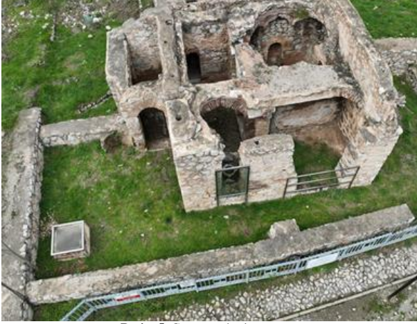
Resim 5. Güney cephesi görünüşü
