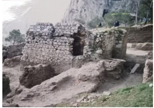
Resim 19. Onarım öncesi kuzey ve doğu cephe görünüşü Kaynak: Samsun Koruma Bölge Kurulu Arşivi
