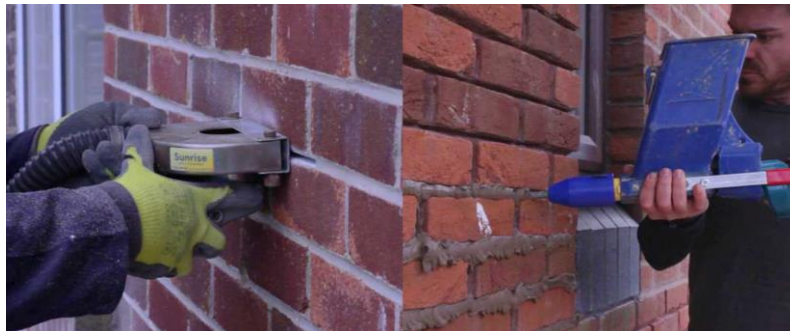
Şekil 7. Tuğla yığma duvar üzerinde derz enjeksiyonunun yapılması [61]. (Grouting on a brick masonry wall [61].)
