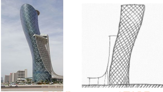
Şekil 6. Capital Gate Tower Cephesi (URL-4, 2022)
