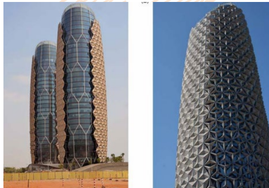
Şekil 7. Al Bahr Kuleleri Cephesi (Attia, 2016)
