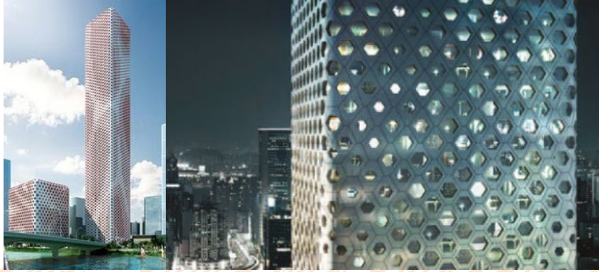
Şekil 8. Sinosteel Uluslararası Plaza Cephesi (Mohamed, Bakr & Hasan, 2019)
