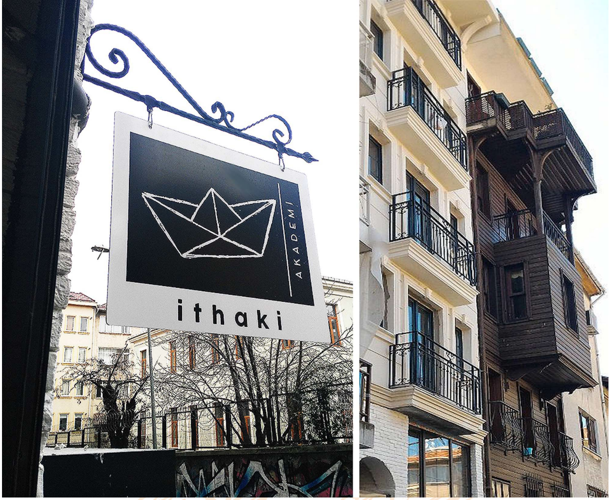
Şekil 4: Dış cephe görüntüsü.
