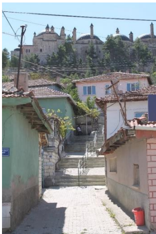
Şekil 30. 112 ada ve 2 parsel arasındaki merdivenli sokak
