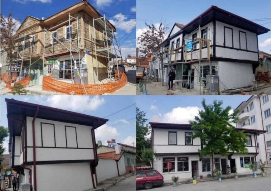
Şekil 32. Uygulama aşamasında Çarşıiçi Caddesi 3 ada 4 parseldeki 2 numaralı yapı
