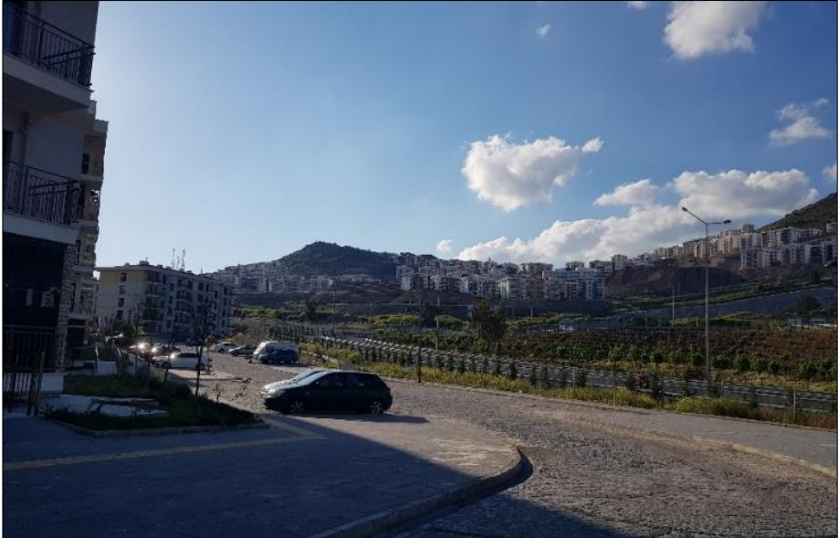
Şekil 9. Bayraklı Rezerv Alanı'nda tamamlanan diğer afet konutları etapları (Fotoğraf yazar Görgülü tarafından çekilmiştir, 2023)
