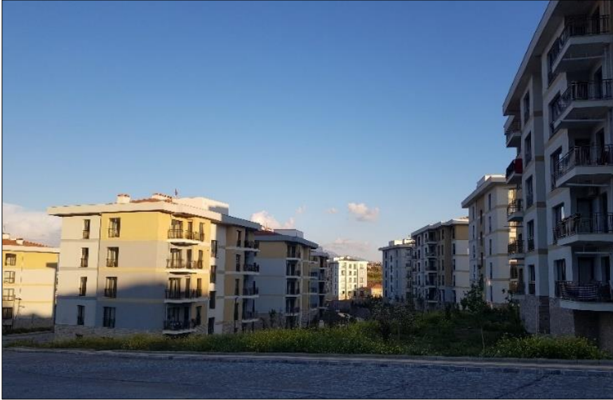
řekil 7. Bayraklı Rezerv Alanı'nda tamamlanan afet konutları (Fotođraf yazar Grgll tarafından ekilmiřtir, 2023)
