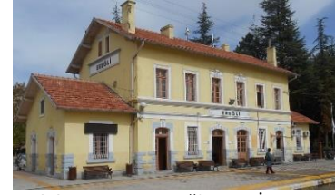
Şekil 1c. Konya-Ereğli Tren İstasyonu
