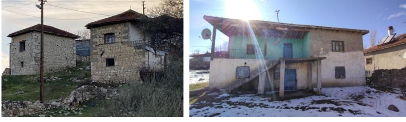
Şekil 27: Taş Malzemeli (sol) ve Kerpiç Malzemeli (sağ) İki Katlı Konutlar (Mehmet Kaan Öztürk Arşivi, 2023)
