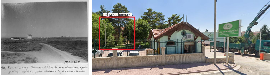
Şekil 9. Yönetim Binasına Ait Eski Bir Görsel (URL 8), Yönetim Binasının DSİ 4. Bölge Müdürlüğü Bahçesindeki Genel Görünüşü (Google Map, 2024)
