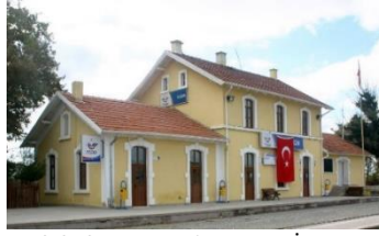
Şekil 1b. Konya-Ilgın Tren İstasyonu
