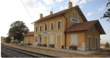
Şekil 1d. Karaman- Böğecik Tren İstasyonu
