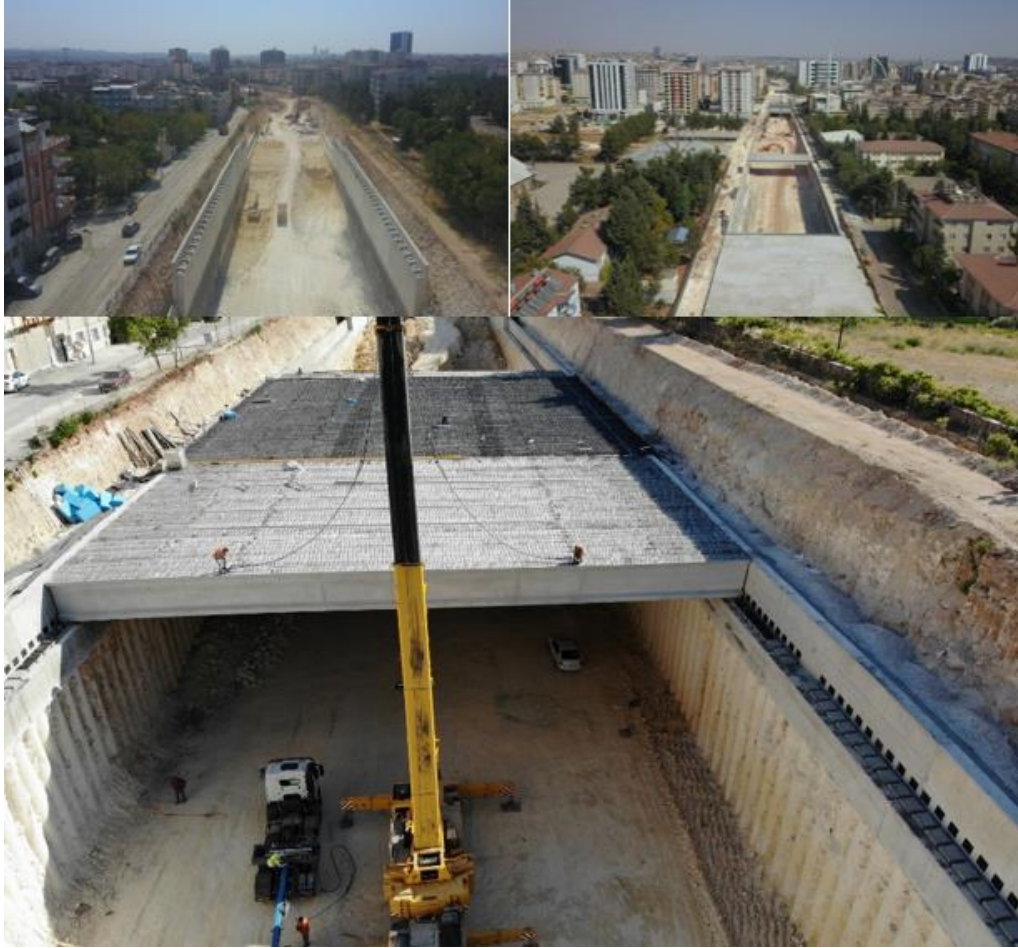
Şekil 3. Aç-kapa tünel yapısına ait kiriş montaj görüntüleri
