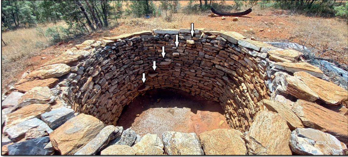
Fotoğraf 3: Avganların temizlik ve bakımında kullanmak için duvarda çıkıntı şeklinde bırakılmış taş basamaklar
