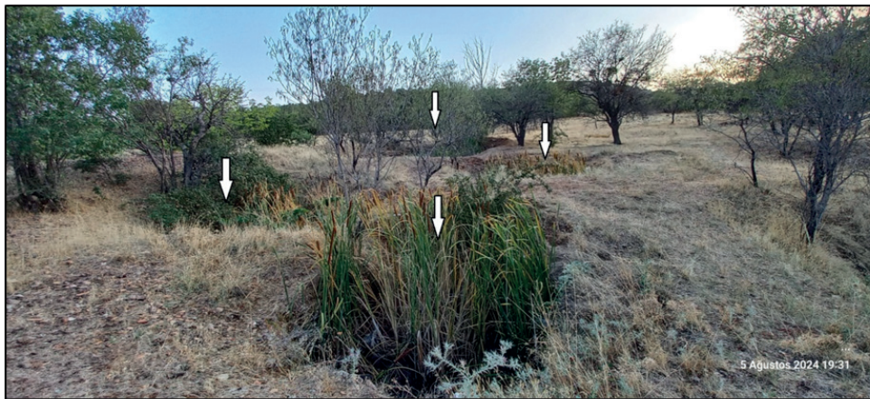
Fotoğraf 7: Geçmiş yıllarda Karahallı'nın içme ve kullanma suyunu sağladığı Dere Avganı sarnıç grubu, bakımsızlık ve duvarlarında büyüyen bitkiler nedeniyle işlevini yitirmiştir
