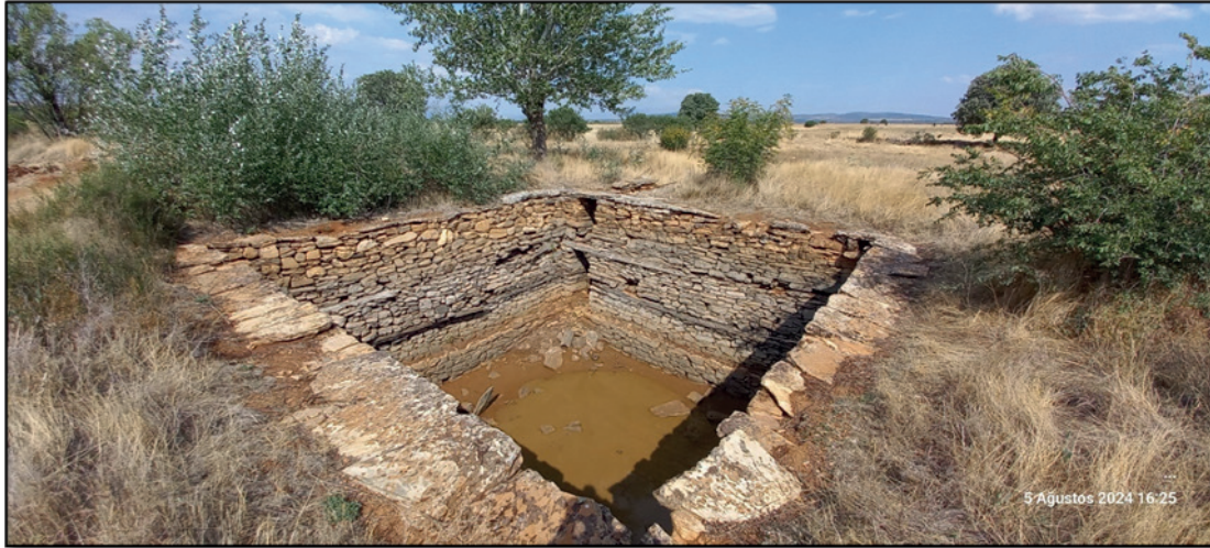
Fotoğraf 2: Kayıklı Köyü'nde bülke adı verilen dikdörtgen plana sahip duvarları taş ve ahşap hatıl kullanılarak yapılmış üzeri açık sarnıcı (38°16.910'K, 029°30.731'D)
