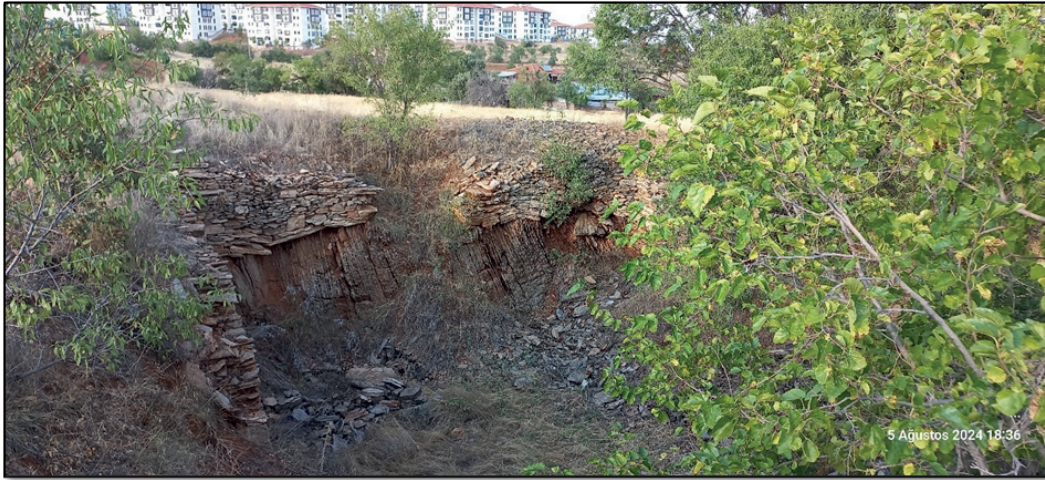
Fotograf 5: Karahallı güneybatısında bir kısmı şistler içinde açılmış üzeri taş duvarla yapılmış bülke
