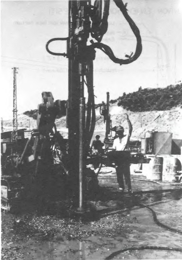
Foto 1- Alüvyonda yapılan sondajdan görünüş
