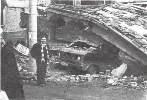
Şekil 20 Erzincan şehir merkezinde zayıf olan birinci katın çökmesiyle yıkılmış çok katlı binalardan biri (çekim güncybatıdan kuzeydoğuya).
