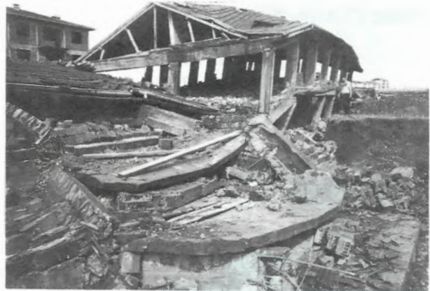
Şekil 18 Erzincan güneybatısındaki bir kooperatifte hemen hemen tamamıyla yıkılmış çok katlı binalar (çekim doğudan batıya).
