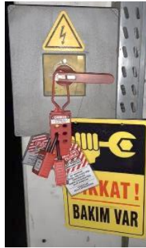
Şekil 4. Otomatik Yatay Kalıplama Hattının Soğutma Tünelinde Derece Devrilmesine Müdahale Çalışması Sırasında EKED Uygulaması (LOTOTO Implementation During the Response Study for Mold Tilt in the Cooling Tunnel of the Automatic Horizontal Molding Line)
