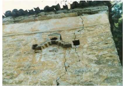
Şekil 42-43. Çatının eski hali – alaturka kiremitli (VGM-1989)
