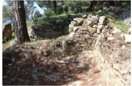
Şekil 81. Z10 Mahal Batı Cephe
