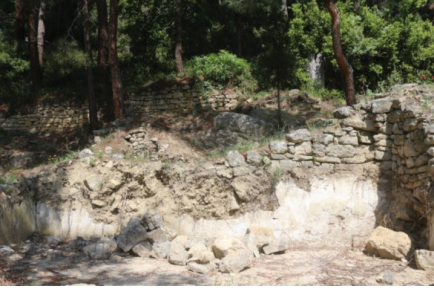
Şekil 72. Z07 Mahal Kuzey Cephe
