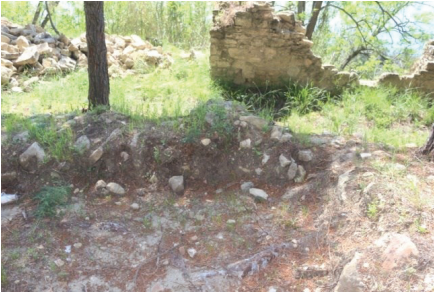
Şekil 80. Z10 Mahal Güney Cephe
