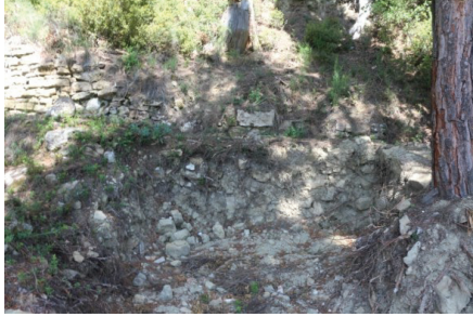
Şekil 62. Z03 Mahal Kuzey Cephe
