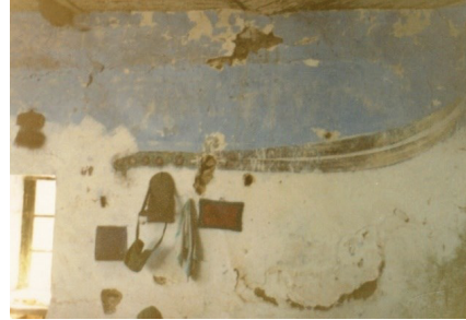
Şekil 47. Türbe Güneybatı Cephenin eski hali (VGM-1989)
