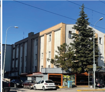
Şekil 4. Yapının yan cephesi
