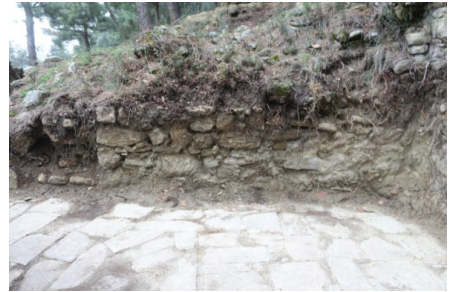
Şekil 69. Z05 Mahal Batı Cephe
