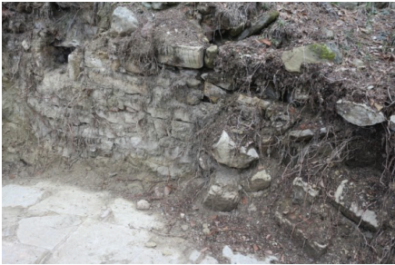
Şekil 68. Z05 Mahal Kuzey Cephe
