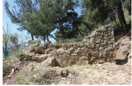
Şekil 67. Z04 Mahal Batı Cephe
