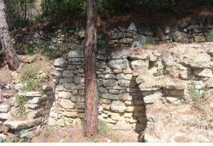
Şekil 82. Z11 Mahal Kuzey Cephe
