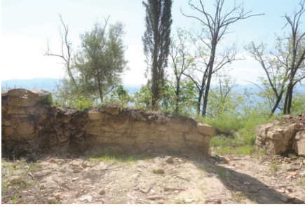
Şekil 66. Z04 Mahal Güney Cephe
