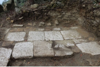
Şekil 74. Z08 Mahal Taş Döşeme
