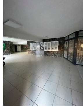
Şekil 6. Yapının bodrum katı
