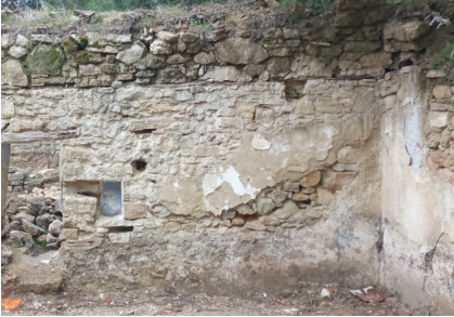
Şekil 46. Türbe Güneybatı Cephe (2023)
