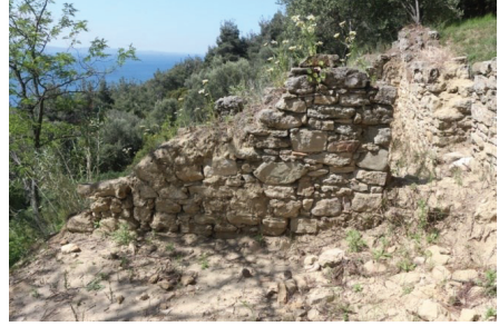
Şekil 89. Z13 Mahal Batı Cephe
