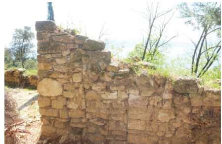
Şekil 71. Z06 Mahal Güney Cephe
