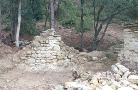
Şekil 60. Z02 Mahal Kuzey Cephe
