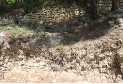
Şekil 76. Z09 Mahal Kuzey Cephe
