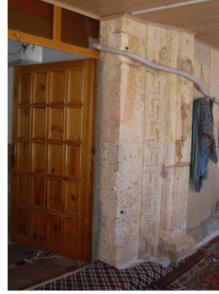
Resim 30. Çavuşin Köyü Ada ? Parsel 1965'deki Yukarı Camii Portali (Toruk, 2010)
