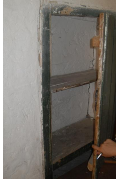
Resim 73. Çavuşın Köyü Ada ? Parsel 1977'deki Konutun Duvar İçi Yüklüğü (Toruk, 2010)
