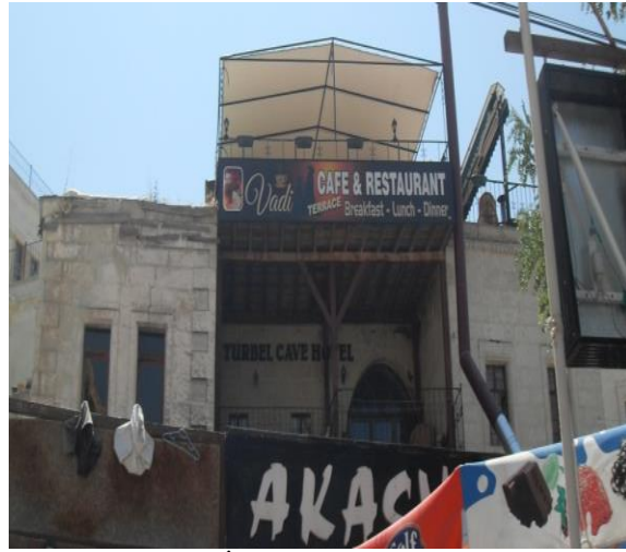
Resim 6. Avanos İlçesi Çavuşin Köyü Ada 3 Parsel 1991’deki Konut (Toruk, 2010)
