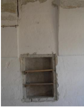
Resim 69. Çavuşin Köyü Ada ? Parsel 1966-67'deki Konutun Duvar Nişi (Toruk, 2010)
