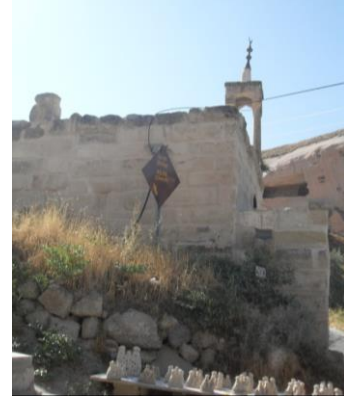
Resim 27. Çavuşin Köyü Ada 5 Parsel Kaya Camii Kuzey Cephe (Toruk 2010)
