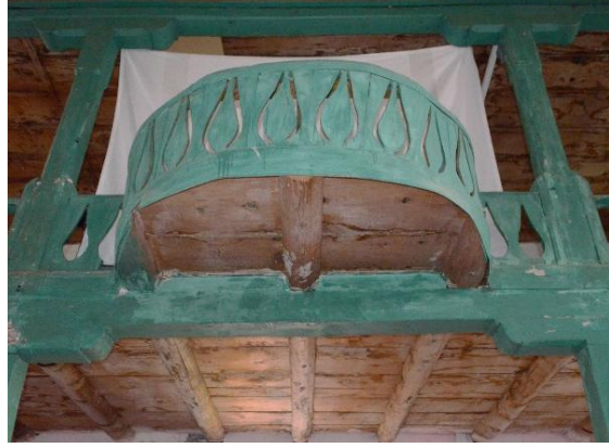
Şekil 19: Cami Mahfil Ahşap Detayı, 2023
