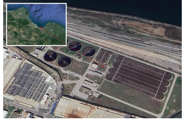
Şekil 1. Samsun doğu ileri biyolojik atık su arıtma tesisi
