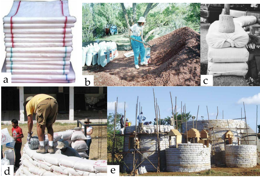
Resim 5. Torba/Çuval Malzemesi (a) (Kulaksızlar, t.y.), Dolgu malzemesi ve katmanlaşma (b) (c) (d) (Hart K., 2018, s.17) (Hunter ve Kiffmeyer, s. 45; Hart, 2018, s. 38), üretim biçimi (e) (Hart, 2018, s. 48-49)
