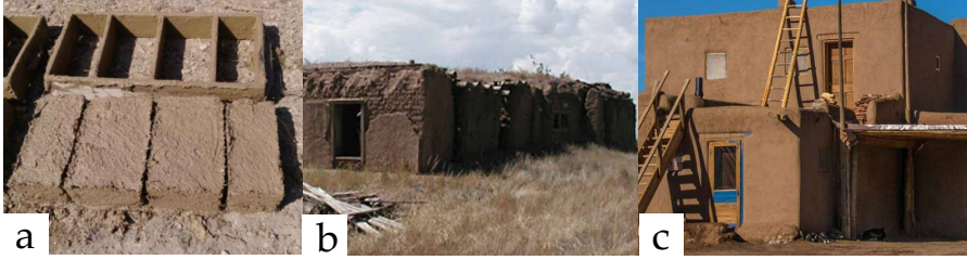
Resim 2. Kerpiç malzeme ve kalıbı (a), yapı elemanı olarak kullanım ile üretilen kerpiç bina örnekleri (b) (c) (İnşaatt, t.y.)
