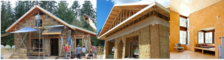
Resim 8. Saman balyaları kullanılarak inşa edilmiş örnek yapıların duvar sistemleri ve iç mekân modern görünüşü (Strawbale.com, t.y.)
