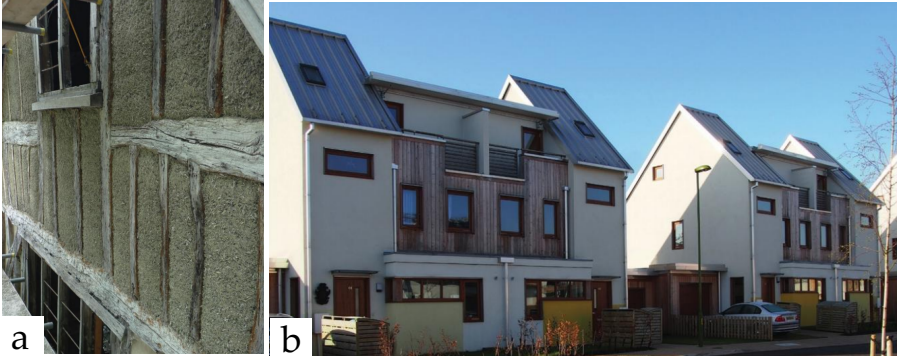
Resim 9. Kenevir esaslı dolgu malzemeleri ile inşa edilmiş ahşap karkas sistemli tarihi bir yapı (a), ahşap elyaf izolasyonu ile kenevir yapı malzemesi ile inşa edilmiş modern yapı örnekleri (b) (Stanwix ve Sparrow, 2014)
