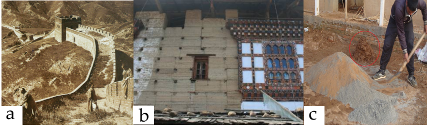
Resim 6. Sıkıştırılmış toprak tekniğinin kullanıldığı Çin Seddi (a) (Cao, 2023), Butan'da yöntemin kullanıldığı Kyichu Lhakhang Manastırı (b) (Jaquin, 2011), sıkıştırılmış toprak malzeme içeriği (c) (Khadka, 2020, s. 124)
