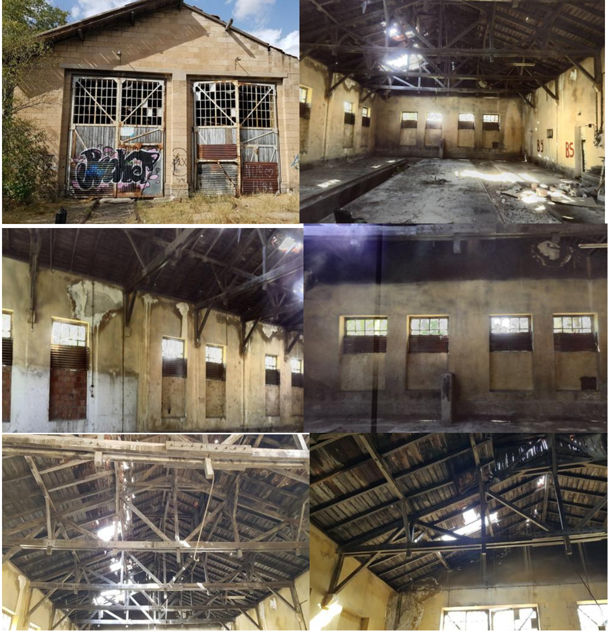
Şekil 4. a. Depo Binası Girişi, b. Depo Binası İçi, c. 6 Adet Pencere Açıklığı, d. 4 adet Pencere Açıklığı, e,f. Üst Örtüyü Taşıyan Ahşap Makas Sistemi
