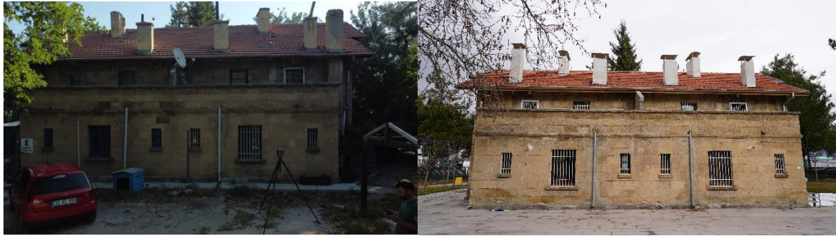
Şekil 7. Lojman Binası Görünümü
