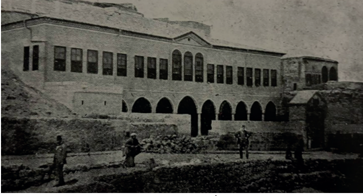
Görsel 7: Nevşehir Rüşdiye Mektebi Binası (Sultan İkinci Abdülhamîd Han Devri Osmanlı Mektepleri, 2007)
