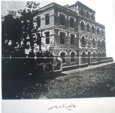
Görsel 2: Fatih Rüşdiye Binası (Kaynak: Salname-I Nezaret-I Maarif-I Umumiye, 1319, s.152. Aktaran, Altınova, 2010).
