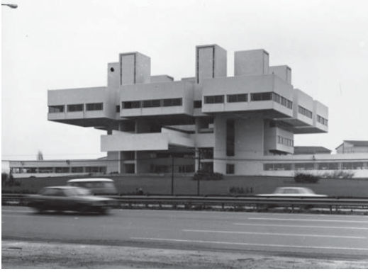
ÜSTTE Tercüman Gazetesi Matbaa ve Yönetim Binası (Salt Araştırma) (Görsel 1)
