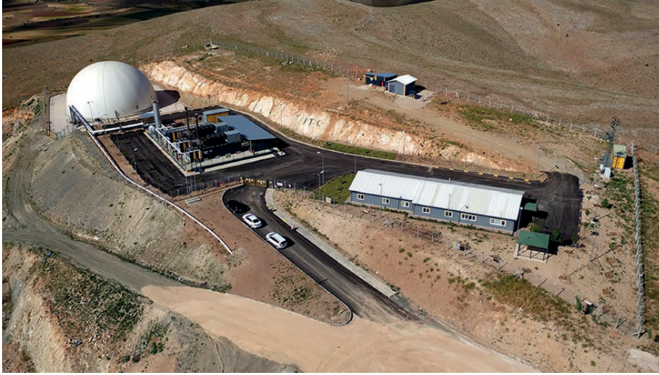
SOLDA Atıktan Enerji Üretim Tesisi. Kaynak: Elazığ'da çöpten..., 2021. (Görsel 6)
