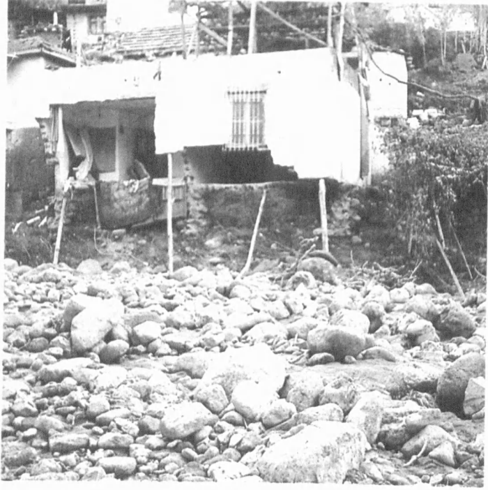
Foto: 17- Kasım 1995. Yamanlar deresi içinde, sel sırasında büyük ölçüde yıkılan kaçak bir yapı.
