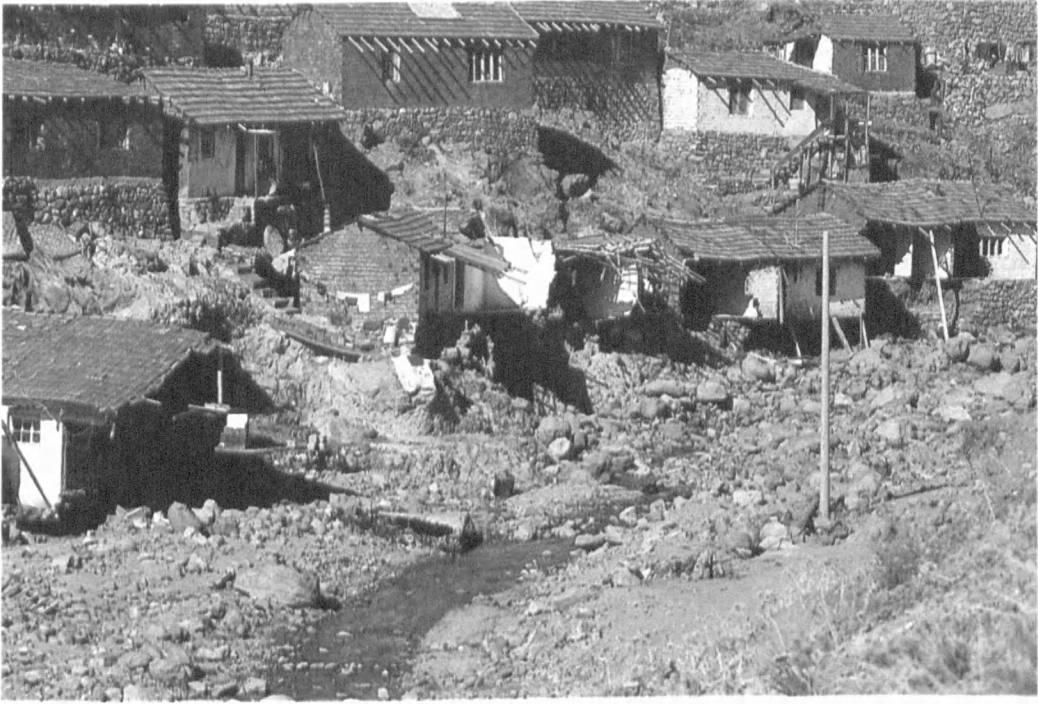
Foto: 3- Kasım 1995. Kavaklıdere vadisinde dere yatağına yapılan kaçak yapılar. Selin son derece etkili olduğu bu kesimde, çok sayıda bina yıkılmış ve can kaybı olmuştur. Bu durum, selin etkisini ağırlaştıran temel faktörün kaçak yapılaşma olduğunu açıkça göstermektedir.
