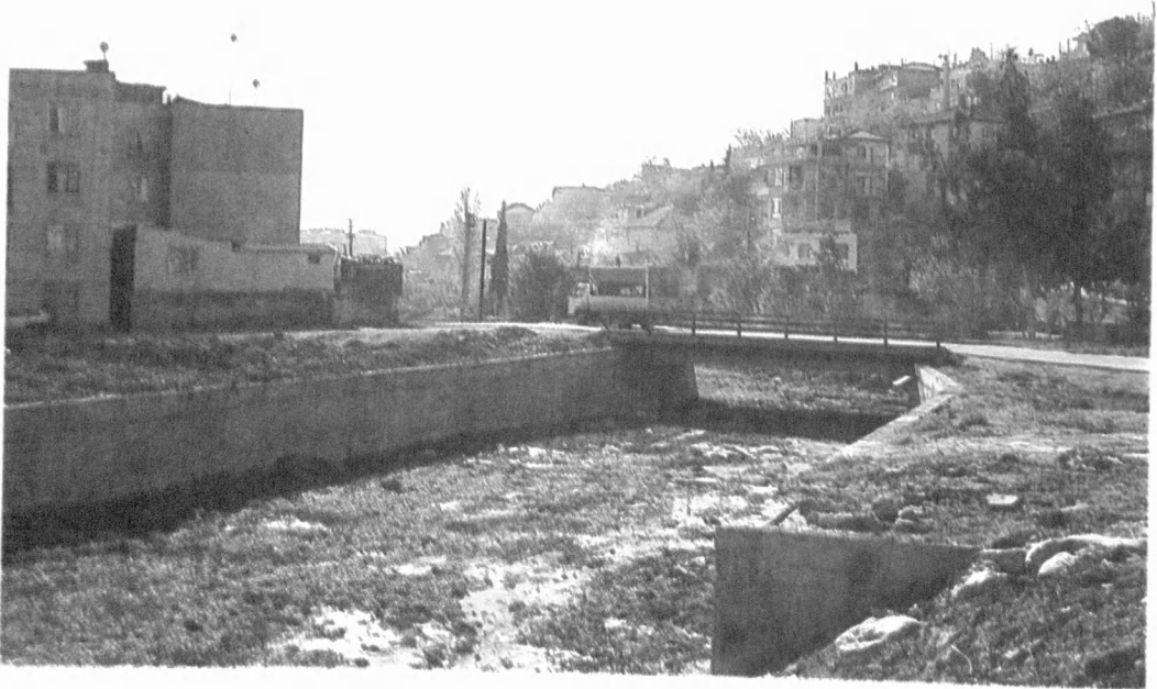
Foto: 10- Kasım 1999. Örnekköy deresi. Daha önce dar büzlerle geçilerek yapılan yol kaldırılmış ve bir köprü yapılmıştır.
