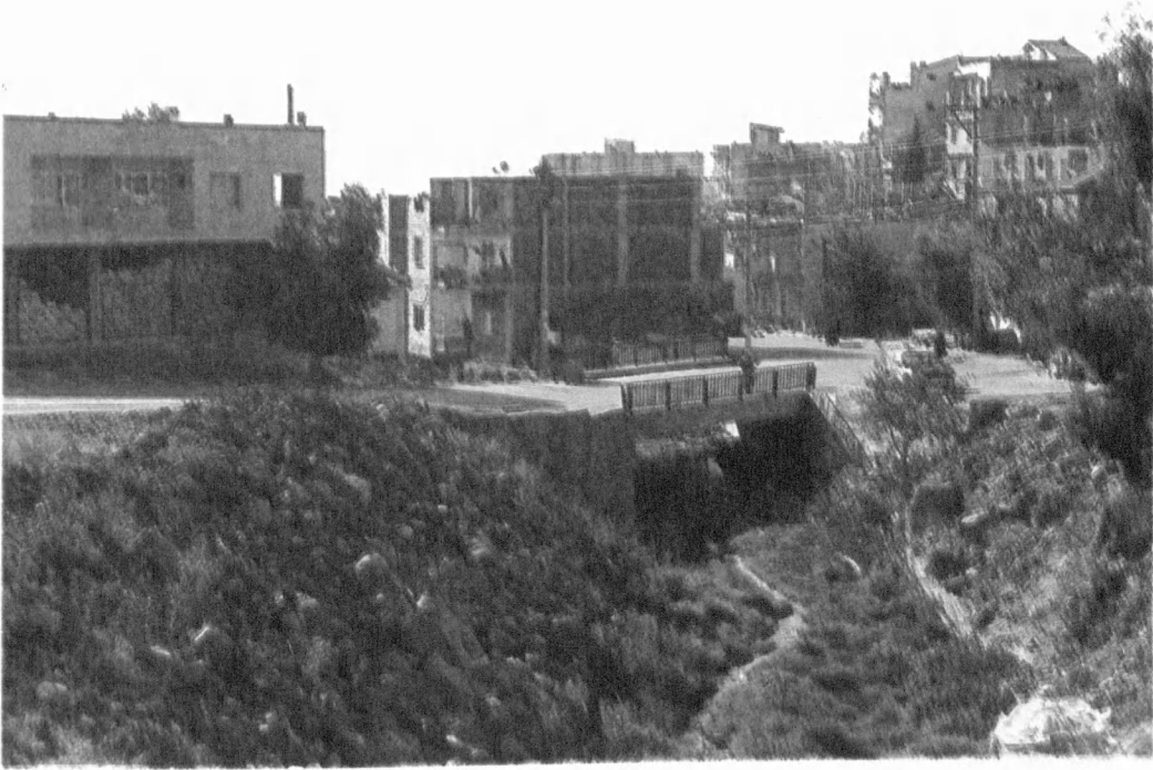
Foto: 8- Kasım 1999. Kavaklıdere vadisi. Foto 7'deki yolun 100 m. güneyinde yer alan yeni köprü. Fakat, sel sırasında baraj etkisi yapabilecek asıl köprü diğeridir ve bununla ilgili çalışma yapılmamıştır.
