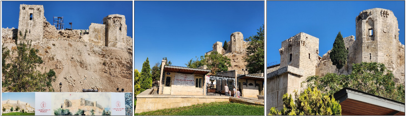
Fotoğraf 1: Deprem Sonrasında Zarar Gören Antep Kalesi'nin Restorasyon Çalışmaları (Mayıs 2024)
