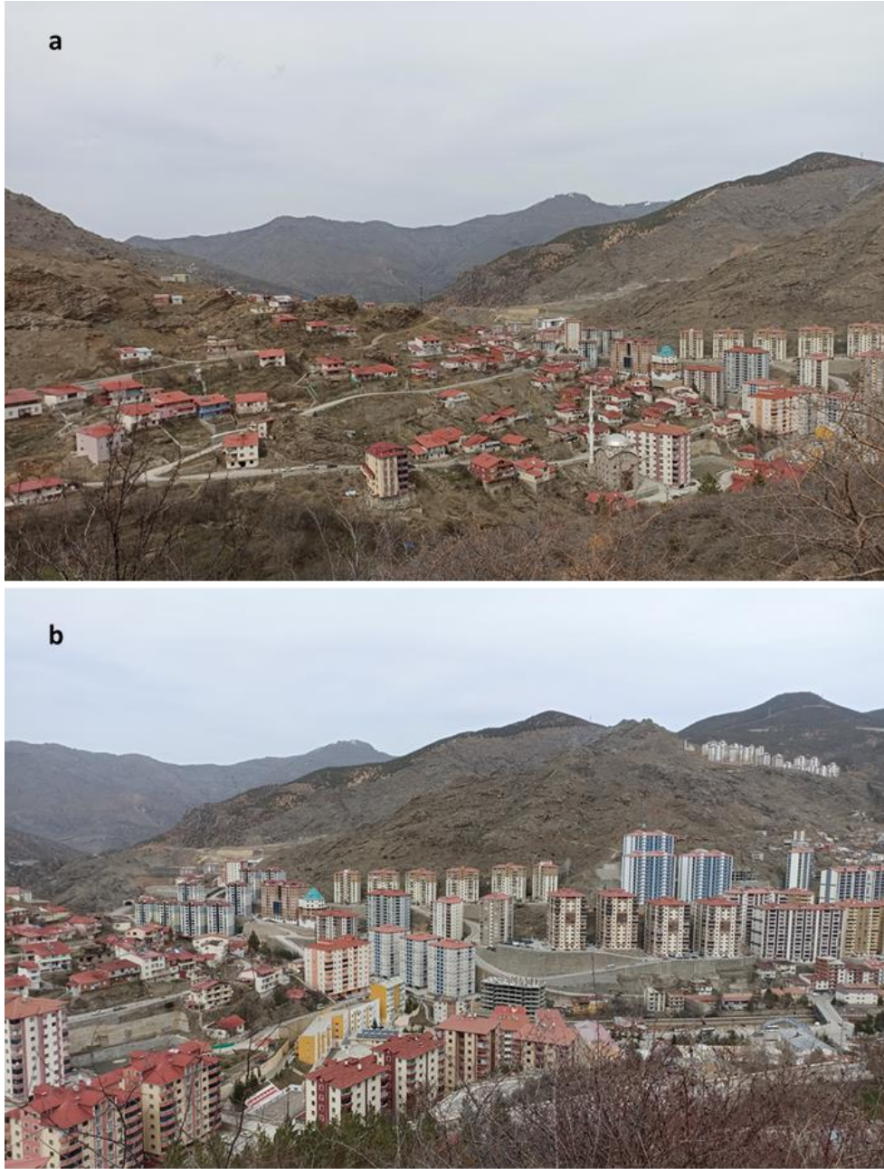
Fotoğraf 1- Gümüşhane kentinin batı ucunda ve Harşit vadisi güneyinde yer alan Özcan mahallesinde geleneksel konutlar (a). Fotoğrafın sağında Oltan Bey mahallesinde yer alan ve eski yapıların yerlerine yapılan çok katlı yüksek yapılar (b).
