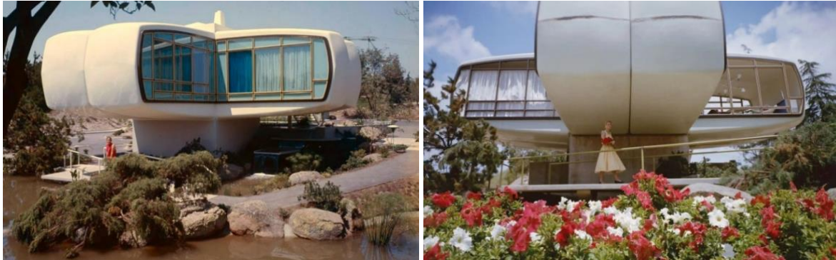
Şekil 16. MHOF'nun inşa edildikten sonraki fotoğrafı ve Şekil 17. MHOF'nun inşa edilen dört kanadından bir tanesi. Kaynak. ( https://www.iconichouses.org/icons-at-risk/monsanto-house-of-the-future )
