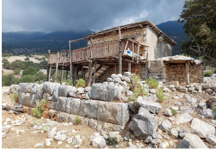
Resim 13. Taş evin güneydoğudan genel görünümü, Helenistik dönem duvarları
