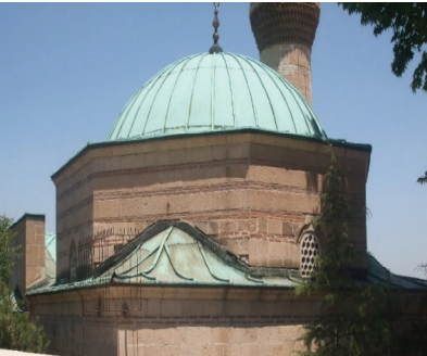
Ek. 12. İshak Fakih Cami Dış Cephedenen Kubbe ve Kasnak Detayı
