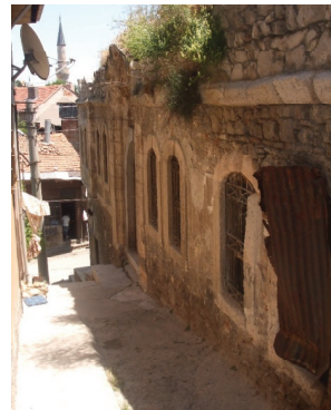
Ek. 19. İshak Fakih Medresesi'nin Restorasyon Öncesi (2014) Kuzey Cephesi ve Giriş Kısmı
