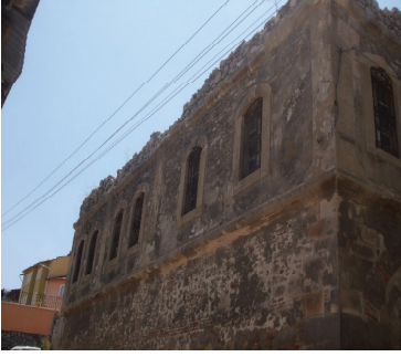
Ek. 20. İshak Fakih Medresesi'nin Restorasyon Öncesi (2014) Doğu Cephesi
