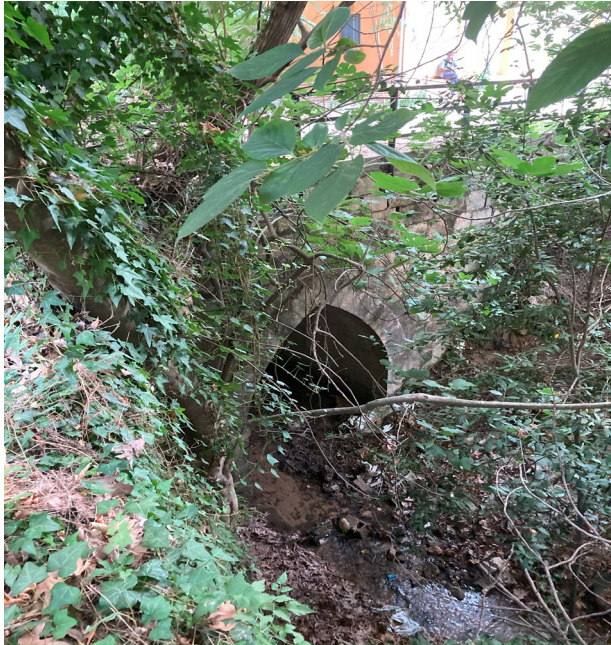
Fot. 7: Harbiye, Şeyh Yusuf el-Hekim Köprüsü mansap cephesine doğudan bakış. (2021)
