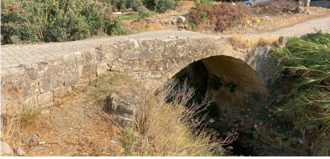
Fot. 11: Karamurt Hanı yakınlarındaki Taş Köprü (2021)
