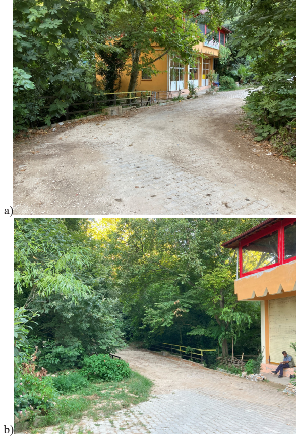
Fot. 4: Harbiye, Şeyh Yusuf el-Hekim Köprüsü; tabliyeye güney (a) ve kuzeyden (b) bakış. (2021)
