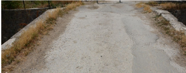
Fot. 14: Muharremşah Köprüsü (Uşak) tabliye düzlemi kornişler. (2017)
