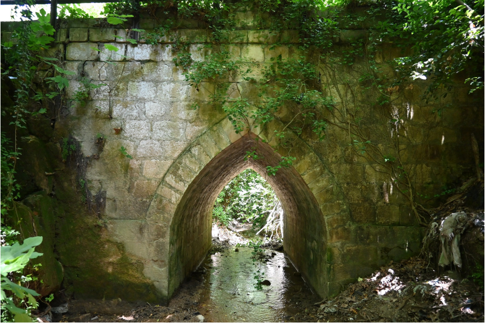
Fot. 5: Harbiye, Şeyh Yusuf el-Hekim Köprüsü menba cephesi. (2025)
