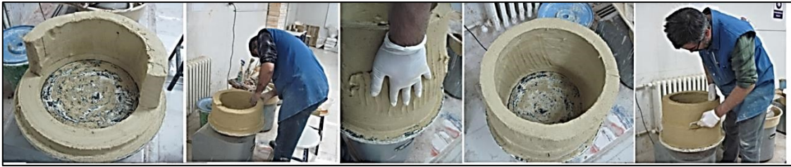
Şekil 8. Taban şablonu üzerine plakaların yerleştirilmesi ile alt kısmın oluşturulması.
