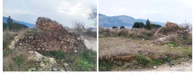
Şekil 12. 6 Şubat 2023 Kahramanmaraş depreminde yıkılmış Alvan Su Kemerî kalıntıları. Figure 12. 6 February 2023 Remains of the Alvan aqueduct destroyed in the Kahramanmaraş earthquake.
