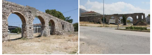
Şekil 11. Alvan Su Kemerî kalıntısı (2022). Figure 11. Remains of the Alvan aqueduct.
