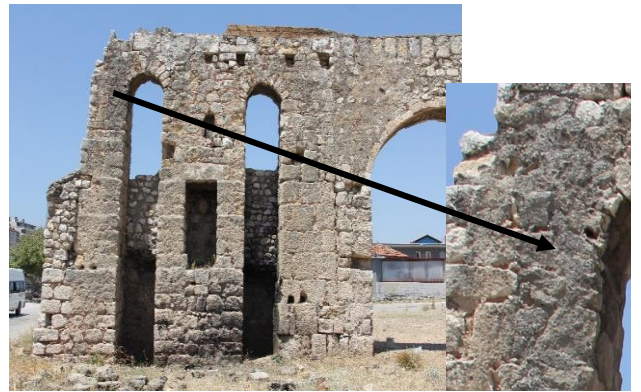
Şekil 8. Alvan Su Kemerleri'nde görülen kararma. Figure 8. Blackening of the Alvan aqueduct.
