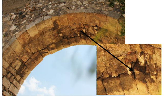
Şekil 7. Alvan Su Kemerleri'nde görülen renk değişimi. Figure 7. Discolouration of the Alvan aqueduct.
