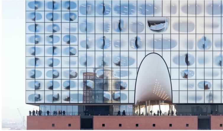
Figure 7. Herzog & de Meuron, Hamburg Elbphilharmonie [20].
