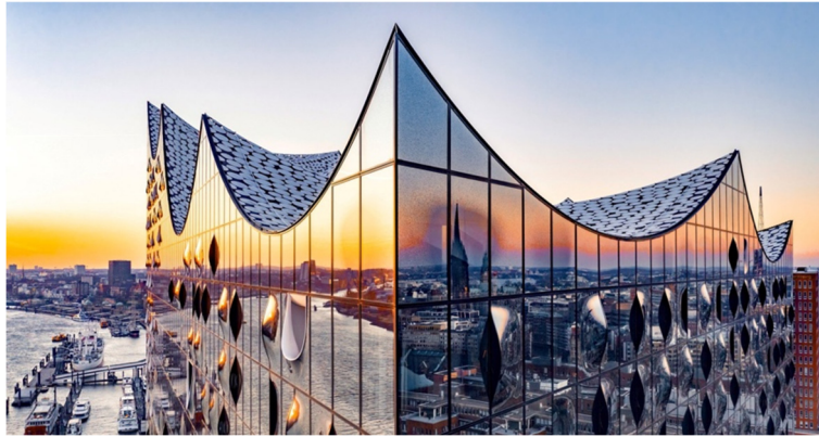
Figure 8. Herzog & de Meuron, Hamburg Elbphilharmonie [21].
