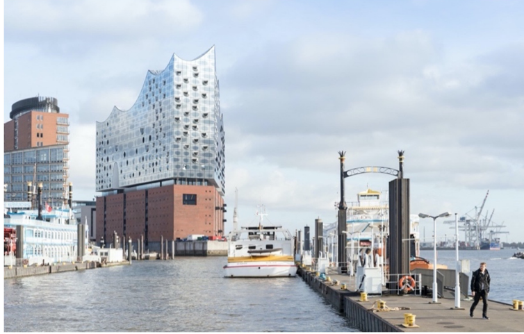
Figure 6. Herzog & de Meuron, Hamburg Elbphilharmonie [20].
