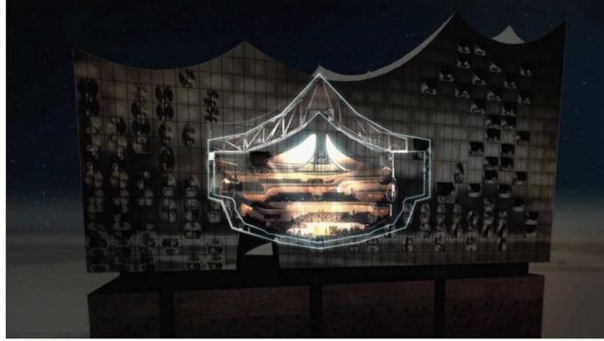
Figure 9. Herzog & de Meuron, Hamburg Elbphilharmonie [23].
