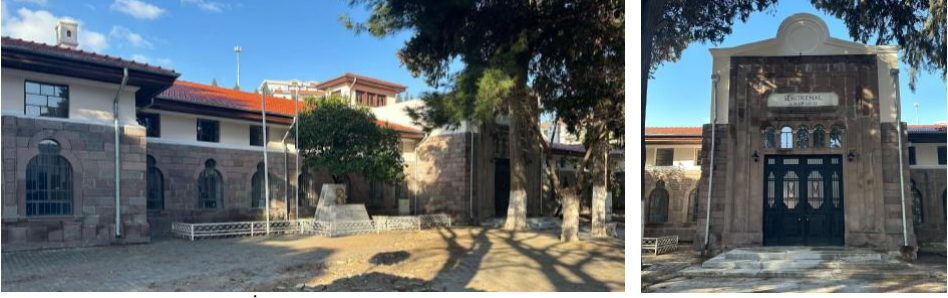
Resim 5. Şehit Kemal İlkokulu doğu cephesi (solda) ve anıtsal giriş kapısı (sağda) (Taşcı, 2024)
